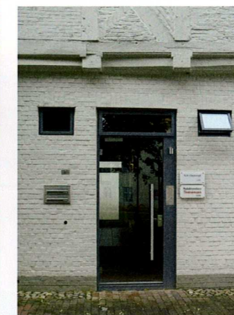
Wieder freigelegte Fassadendetails mit modernen Ergänzungen
